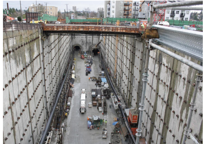
Figura 4. Construcción pública de vialidades subterráneas en Seattle, EUA. Fuente: http://kuow.org/post/has-sound-transit-been-buying-public-land-cheap
