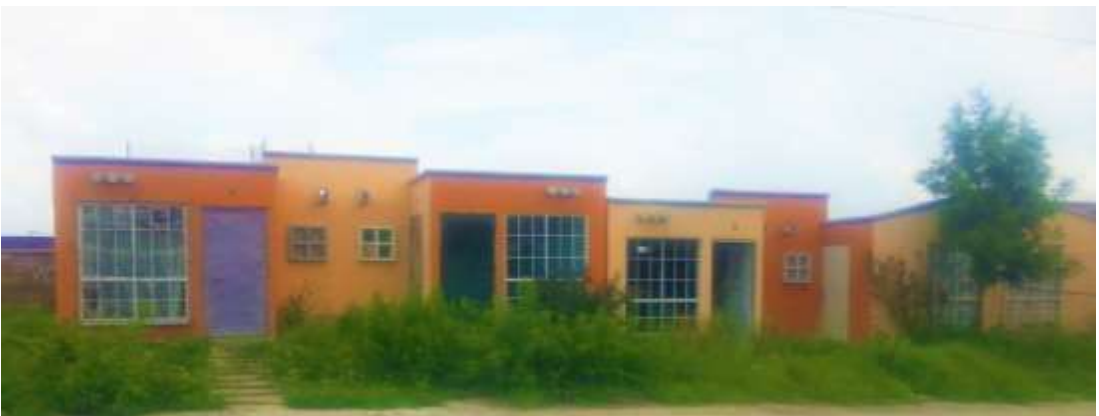
Sección: La glorieta 3, la zona conflictiva del Fraccionamiento La Trinidad dentro del apartado 7.5 Ejemplos de bardas con el grafiti 13 UCK y de casas “abiertas”.
