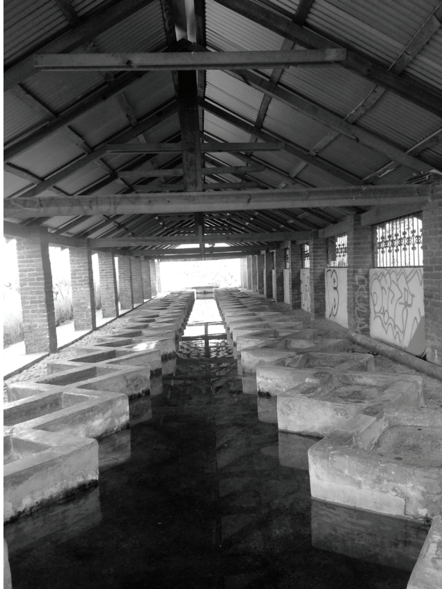
IMAGEN 2. Lavaderos hincados construidos en 1923. Acervo personal de la autora, 24 de octubre de 2019.
