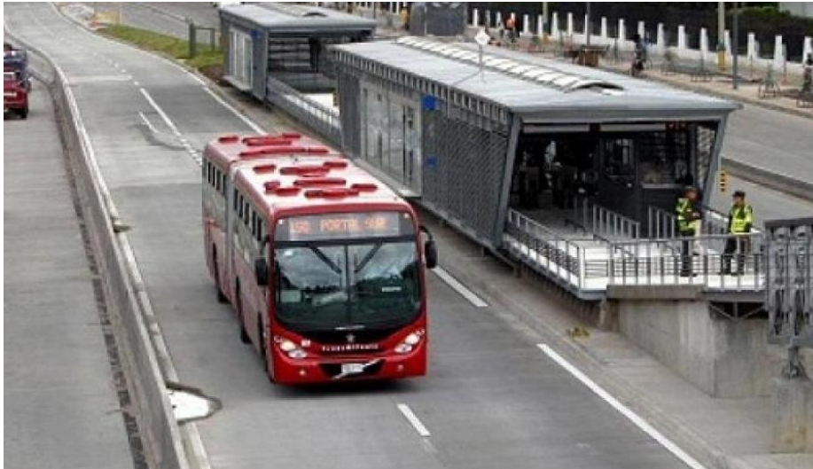
Imagen 3 Estación del Sistema Transmilenio de Bogotá
