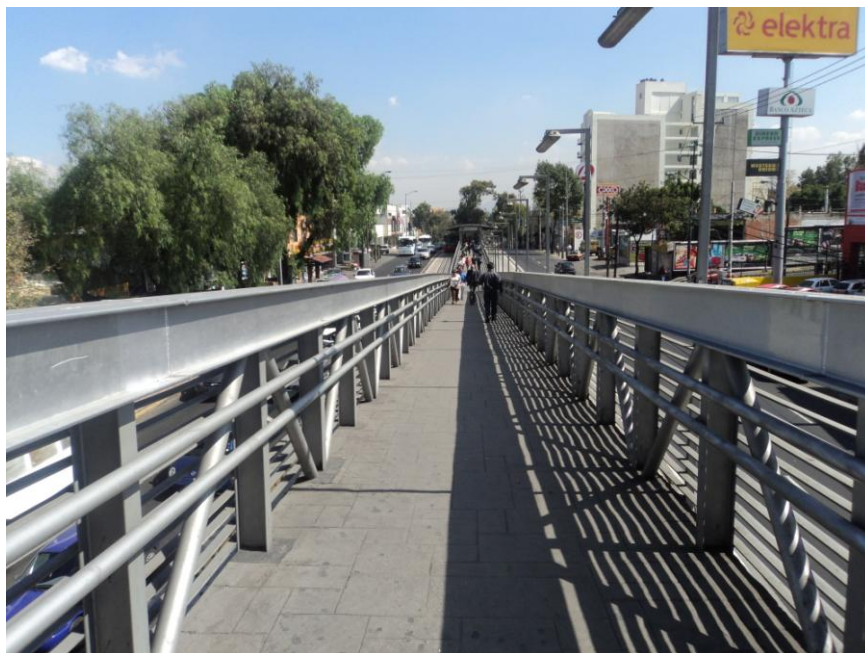
Imagen 14 Puente peatonal construido para el Metrobús en la estación Villa Olímpica
