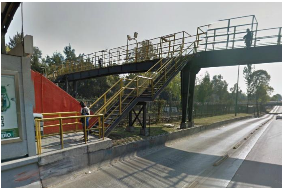
Puente peatonal acondicionado para dar servicio a la estación Potrero
