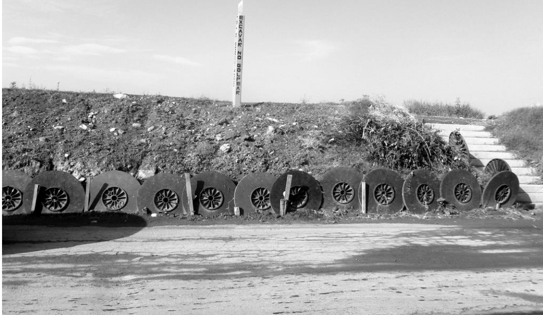
Imagen 6. Diques con discos de plástico en el perímetro del Río de los Remedios.
