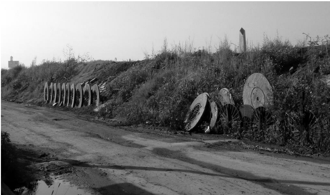
Imagen 7. Diques con discos de plástico en el perímetro del Río de los Remedios.
