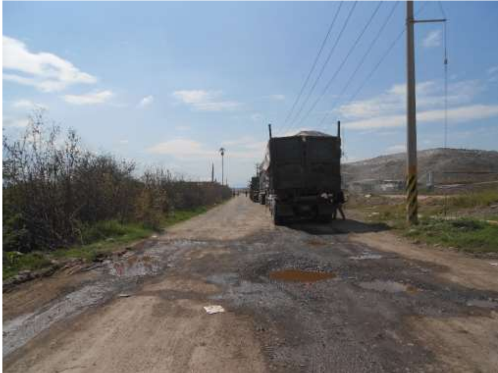
Vía de acceso a “La Perseverancia”
