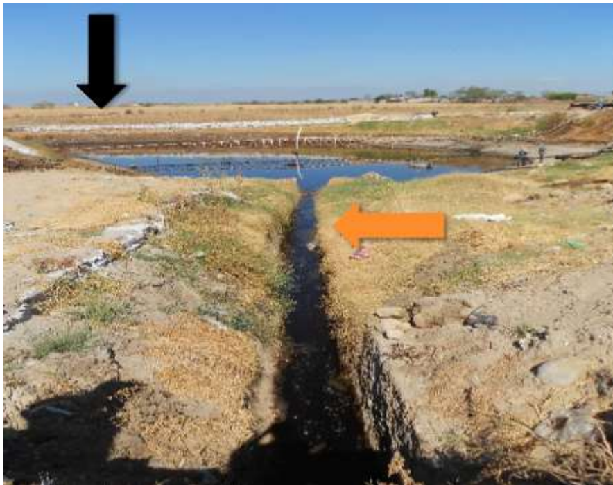
Canal de lixiviados expuesto al aire libre. Relleno sanitario “La Perseverancia”
