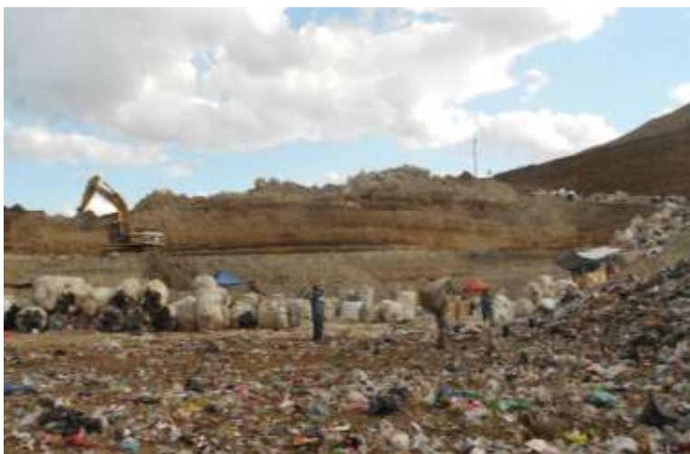
Construcción de una nueva celda de flotación en el relleno sanitario “La Perseverancia” Foto: elaboración propia
