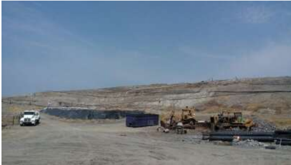
Instalación de tubería para la generación de electricidad en “La Perseverancia”
