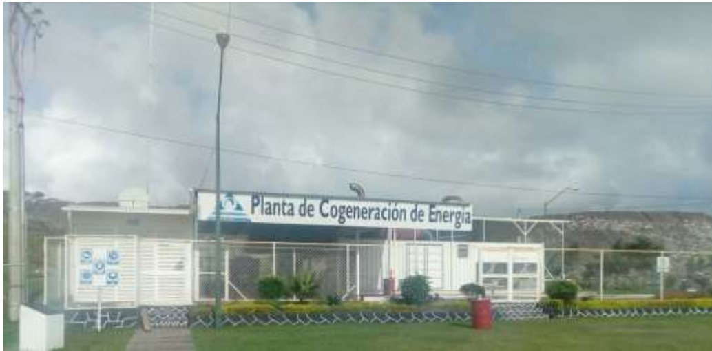
Área de acceso a “La Perseverancia”
