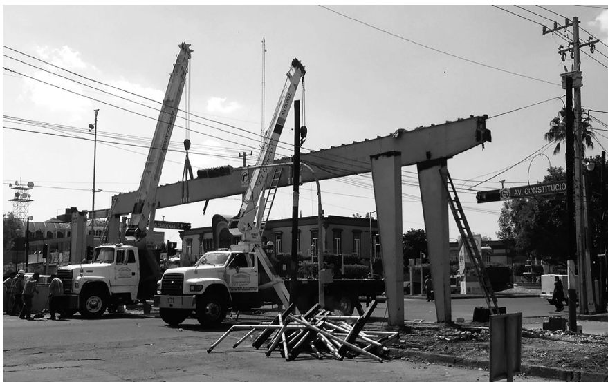
Figura 5. Retiro del puente peatonal en la intersección de Lázaro Cárdenas y Constitución, en Sahuayo, Michoacán, para ser sustituido por un cruce semaforizado a nivel de calle.
