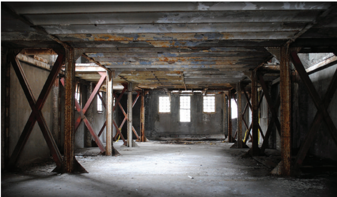
Figura 10.7. Vista de segundo piso. Etgar Pérez, 2018
