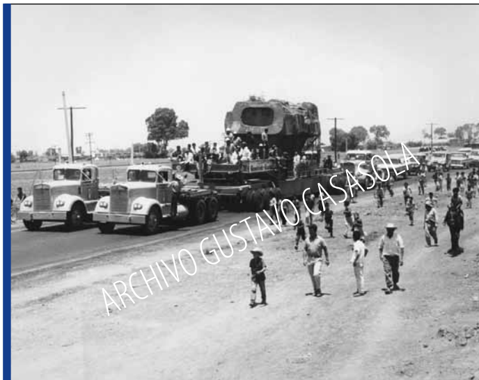
Para poder trasladar el monolito de varias toneladas de peso, fue necesario construir una plataforma de seis ejes con 24 llantas para poderlo llevar al Museo de Antropología e Historia en Paseo de la Reforma el 16 de abril de 1964. Además de esto, fue indispensable que la Compañía de Luz y Fuerza cortara los cables de luz para que pudiera transitar por las calles de la ciudad de México. Archivo Gustavo Casasola.
