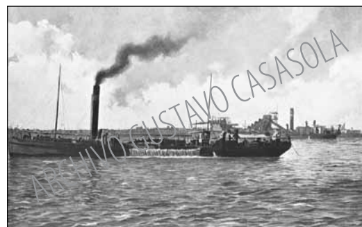
Imagen tomada de la draga México haciendo su labor para limpiar el fondo del mar y dejar los diez metros necesarios para que entraran los buques de gran calado al puerto de Veracruz. Archivo Gustavo Casasola.
