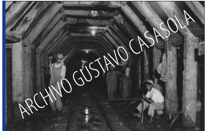
Túneles donde se introdujeron las tuberías.
