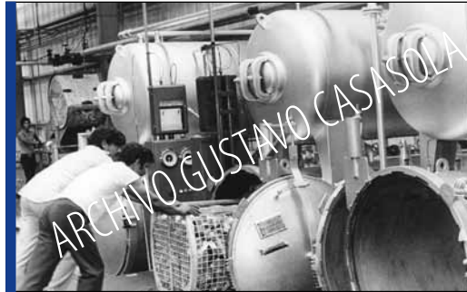
En estos programas de impulso a la industrialización del país se puso especial cuidado a la industria pesquera. En la imagen se observa el proceso de esterilización y lavado de las latas de atún y sardina. Archivo Gustavo Casasola.
