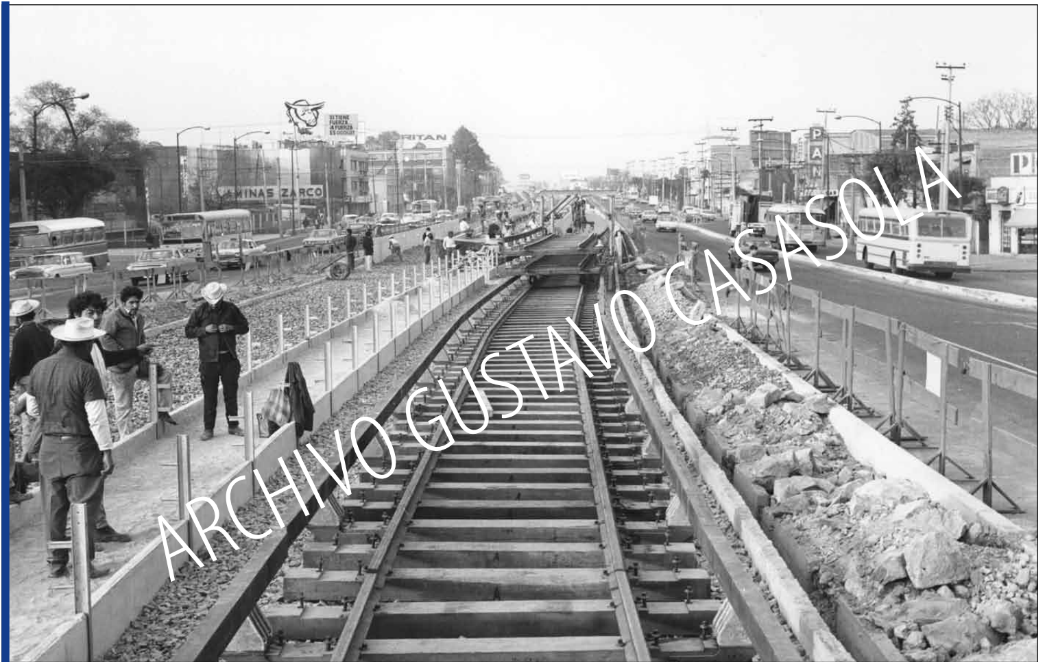
Maniobra de colocación de rieles para los vagones del metro sobre Calzada de Tlalpan en 1969. Foto: Sistema de Transporte Colectivo, Archivo Gustavo Casasola.
