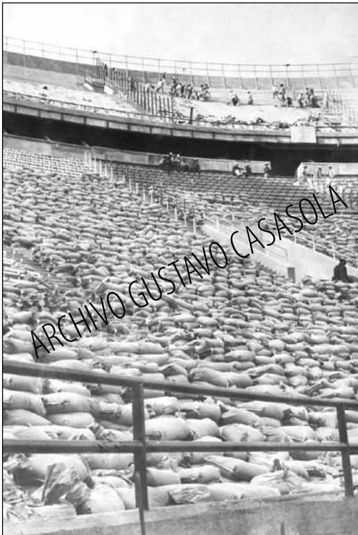
En enero de 1946 se realizó la prueba de resistencia con sacos de arena en la recién construida Plaza de Toros México. La plaza fue inaugurada el martes 5 de febrero del mismo año. Foto: Olivares, Archivo Gustavo Casasola.
