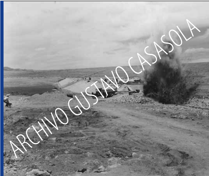
El gobierno del general Cárdenas apoyó la comunicación abriendo caminos y carreteras. En la imagen vemos el momento en que se utiliza la dinamita para romper las rocas y emparejar el terreno. Archivo Gustavo Casasola.
