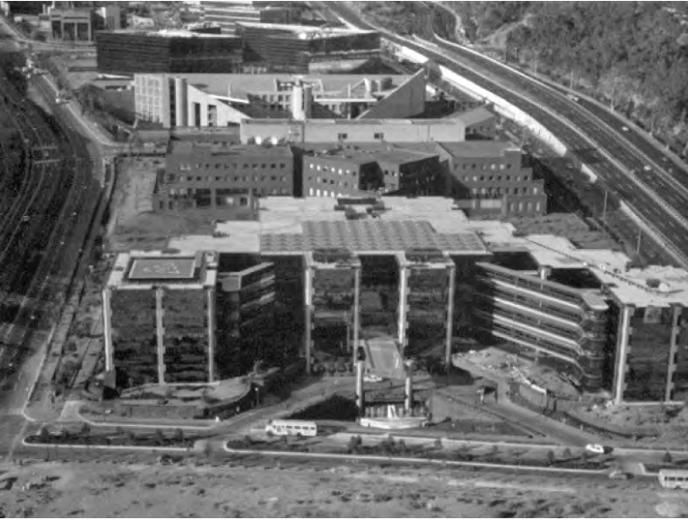
Fotografía 5. Primeros edificios corporativos en el área. FUENTE: fotografía cortesía de Servimet.
