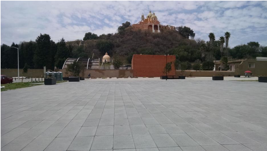
Vista del lado este de la pirámide de Cholula que colinda con la calle 5 norte en terrenos de San Andrés. Se observan las modificaciones al espacio los terrenos y una parte del ex convento de San Gabriel. Fotografía tomada el 22 de marzo del 2016.
