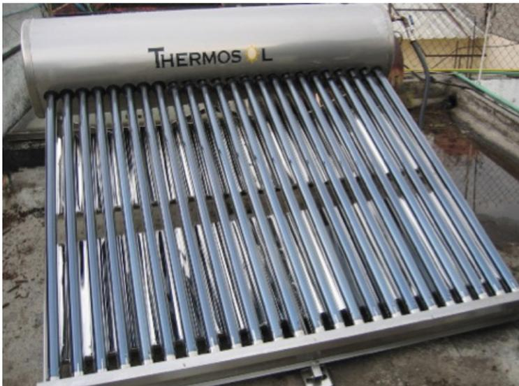
Figura 18. Calentador solar doméstico de agua
