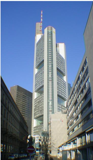
Introdujo sistemas híbridos de climatización, de iluminación, acústicos y para el control de ruidos. Para ello utilizó un patio de luz y ventilación al centro de la planta, con entresijos transparentes que evitan el efecto chimenea, y una secuencia de terrazas que van girando de manera helicoidal en la vertical del edificio (figuras 4, 5, 12, 13, 8 y 7).
