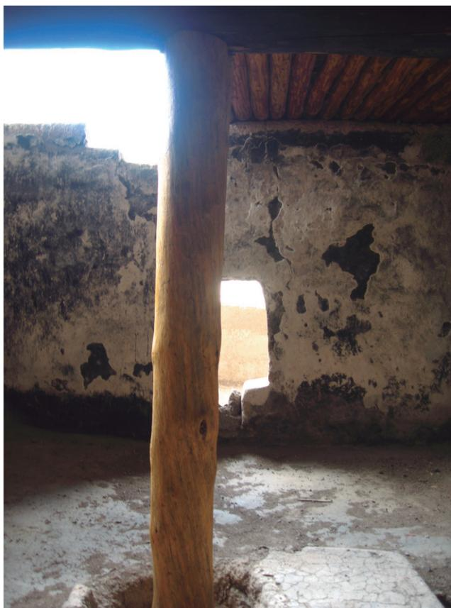
Estructura de madera, el techo está tejido de un entramado de delgados palos con una superficie de tierra que en conjunto son el sistema constructivo utilizado en la zona.
